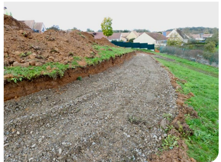
Une vue du chantier au mois de novembre 2022
